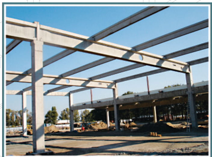
Каркас ТЦ „МЕТРО С&С”, м. Дніпропетровськ
