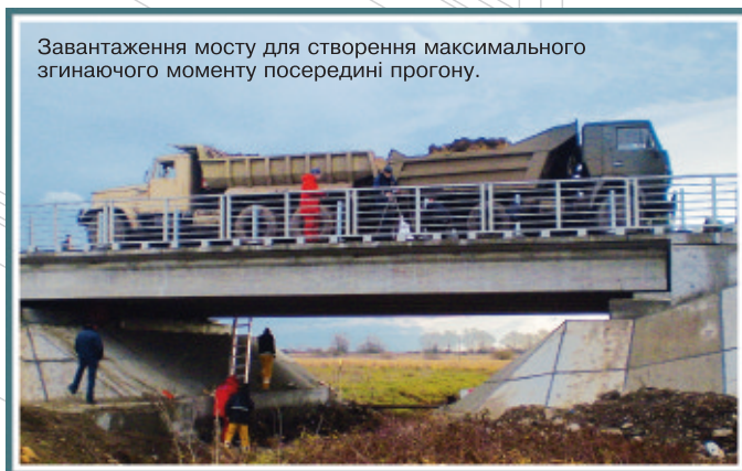
Міст через р. Стрв'яж, Львівська обл.
